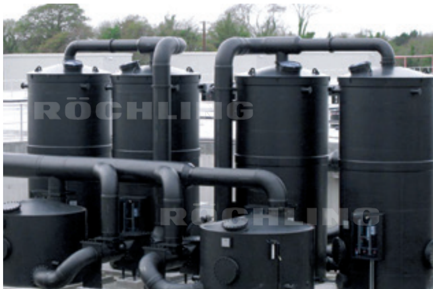
Polystone® G black B 100 用于废水处理设备的空气净化系统
