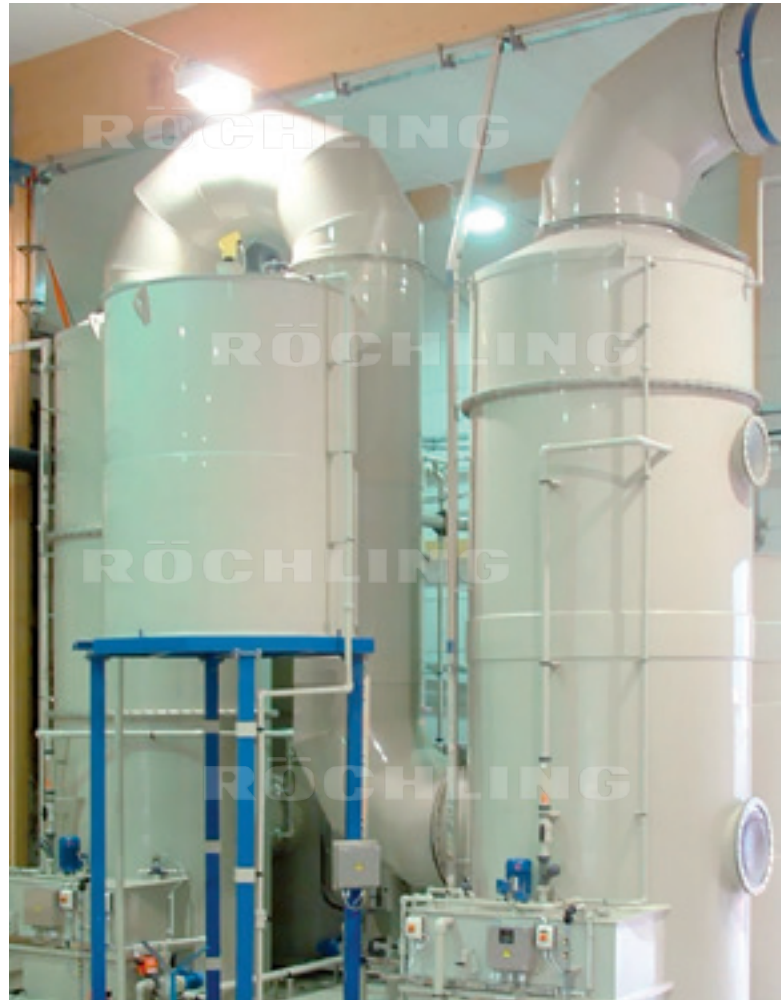
在废气处理设备中使用的气体和液体通常具有很强的腐蚀性，因此需要使用具备抗腐蚀性的热塑性塑料。
