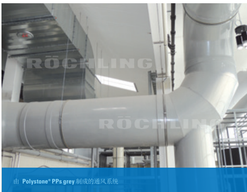
Polystone® P homopolymer grey 电镀设备通风系统
