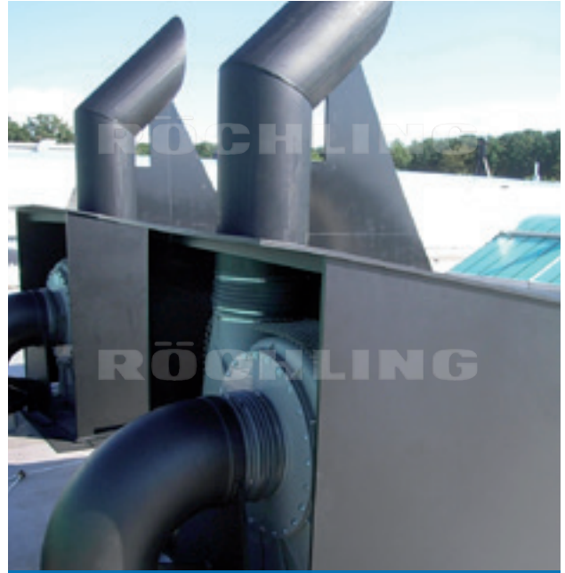
Polystone® G HD black 大厅屋顶通风设备外罩 这里对耐候性有强制要求
