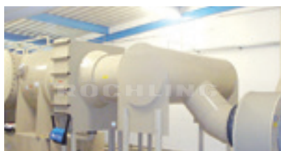
由 Polystone® P homopolymer grey 制成的气体洗涤器
