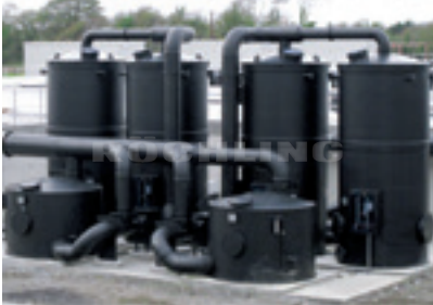
Polystone® G black B 100 用于废水处理设备的空气净化系统
