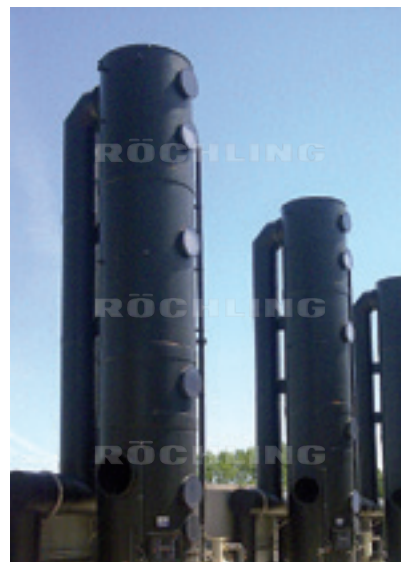
Polystone® G black B 100 用于家庭垃圾分类设备的废气洗涤塔
